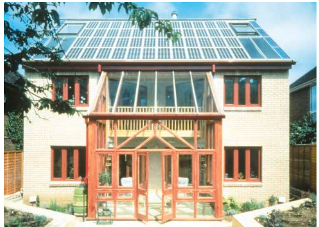
Bild 6 Indachmontage von BP-Solarmodulen
