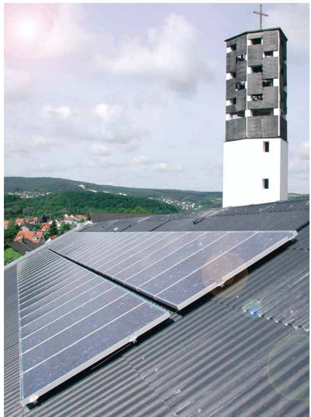
Bild 3 Aufdachmontage auf Berliner Welle
