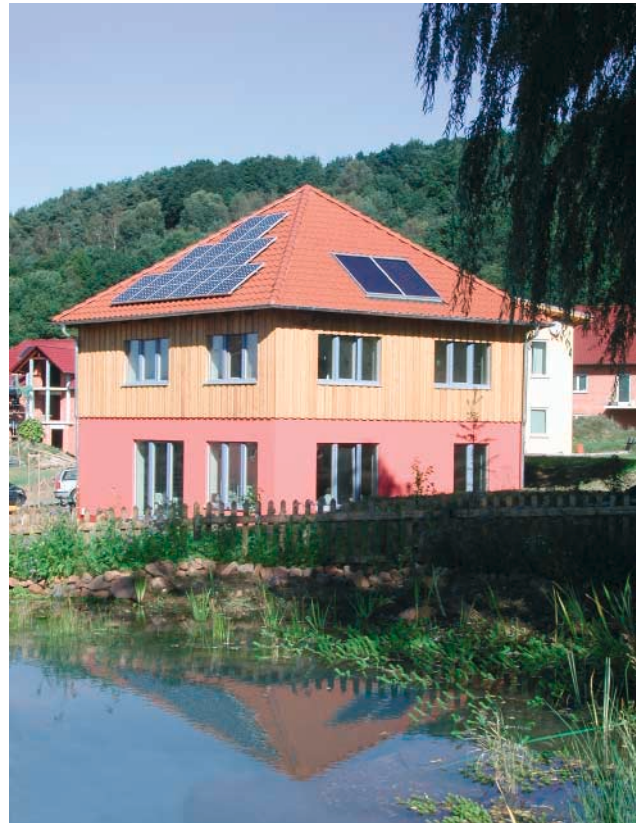
Bild 2 Aufdachmontage auf Pfannendach
