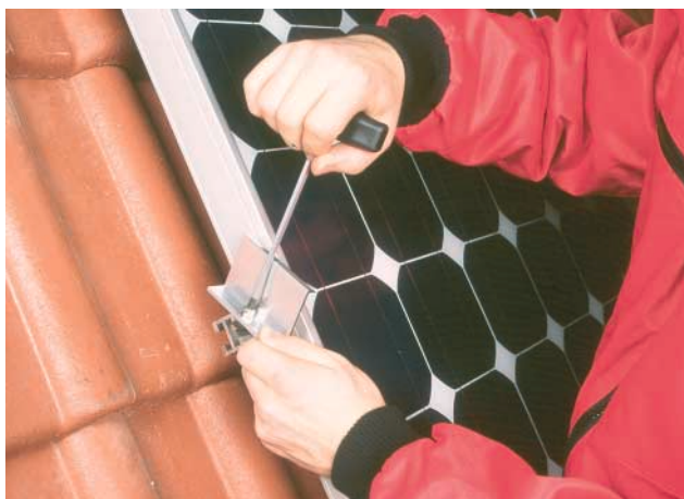
Bild 17 Befestigungsklemmen fixieren das Solarmodul einfach, schnell und sicher.
