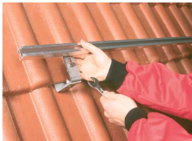
Bild 16 Sparrenanker bieten einen sicheren Halt für Solarstromsysteme auf Ziegeldächern. Mit der Hammerkopfschraube wird eine einfache und sichere Verbindung zwischen Sparrenanker und Montageschiene geschaffen.
