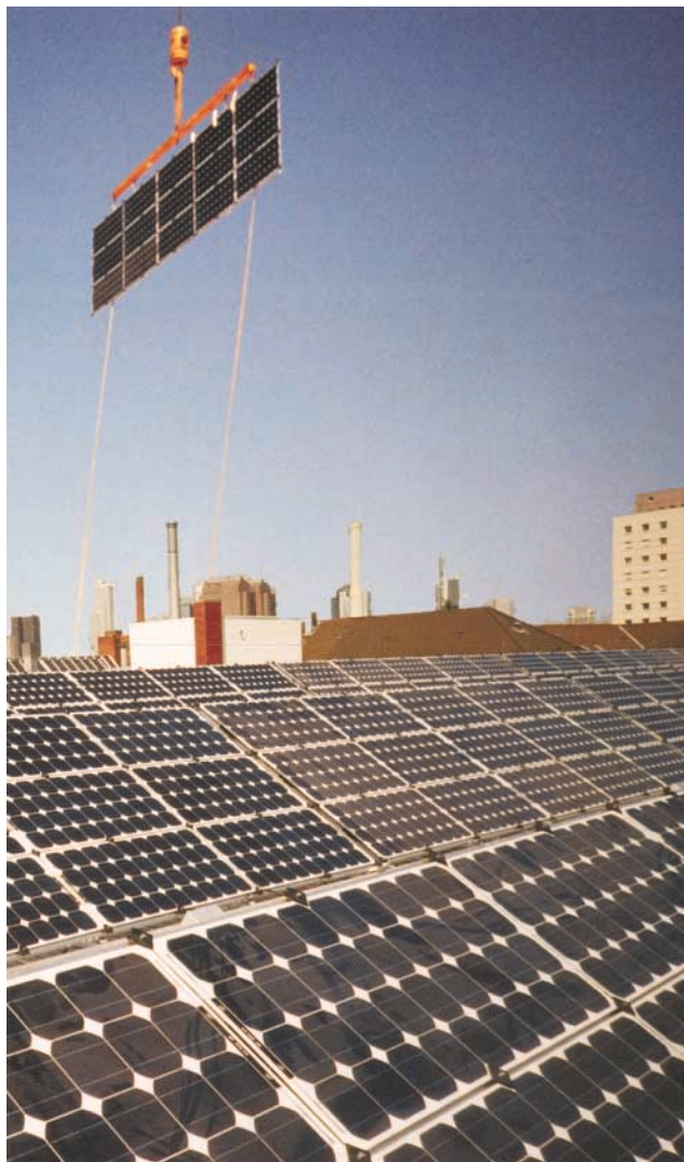
Bild 9 Flachdachmontage von Modulfeldern mit Autokran
