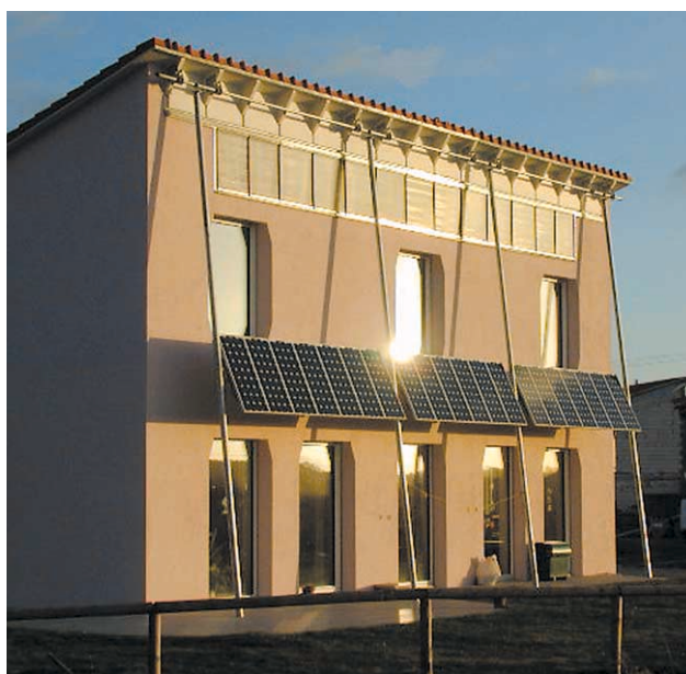
Bild 10 Wandmontage von solarmodulen – ein schöner Blickfang
