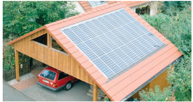
Bild 5 Indachmontage auf einem Carport
