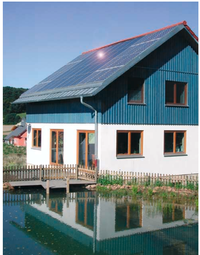
Bild 7 Indachmontage von Solarmodulen kombiniert mit themischen Kollektoren
