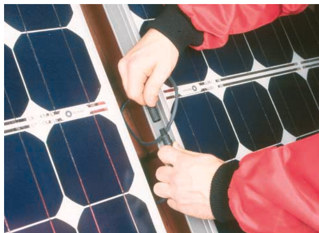
Bild 18 Der Multikontaktstecker schafft rasch eine elektrische Verbindung.
