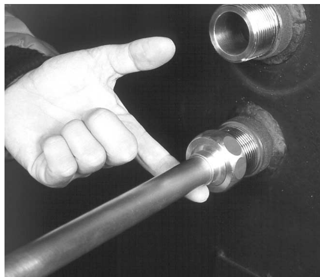
Bild 9 Fertig! Nach Inbetriebnahme alle Anschlüsse nochmals auf Dichtigkeit prüfen und ggfs. nachziehen.
