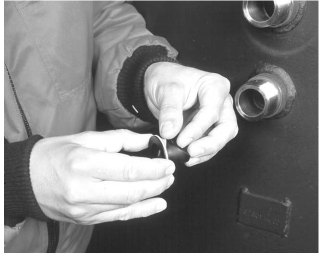
Bild 5 Schutzpapier von der Klebedichtung entfernen und auf den Bund der CONVECTROL II aufkleben. Zweites Schutzpapier entfernen und ...
