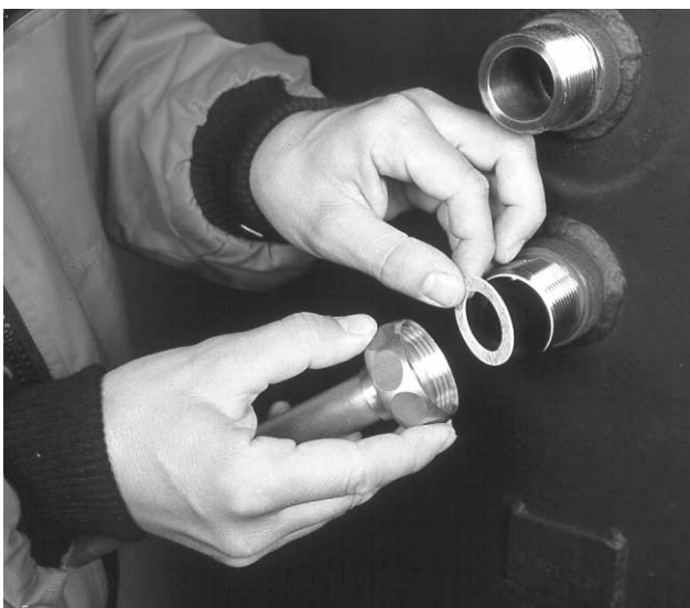
Bild 8 Einbaulage der CONVECTROL II nochmals überprüfen: Markierung nach oben! Zweite Flachdichtung einlegen und Überwurfmutter verschrauben. Einlegeeteil darf nicht mitdrehen!
