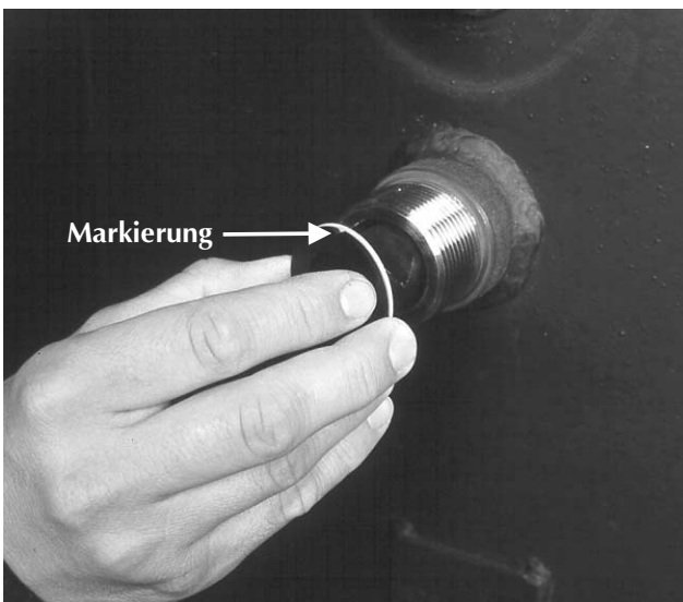
Bild 6 ... nach der Säuberung der Stirnfläche von Schmutz und Ölresten CONVECTROL II mit der Markierung nach oben in den Stutzen hineindrücken.
