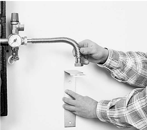
Bild 13 Lage des Ausdehnungsgefäßes bestimmen, Löcher für Befestigungswinkel im senkrechten Abstand von 210 mm mit 12er Steinbohrer anbringen und Halterung mit Schrauben 8x60 montieren.
