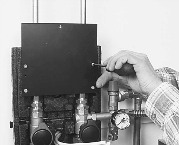
Bild 17 Regler-Montageplatte auf Isolierschale schrauben und Unterteil des SunGo-Reglers darauf befestigen.
