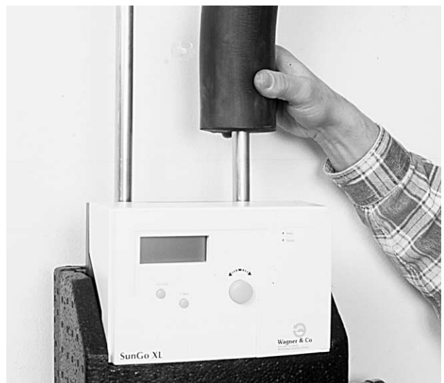
Bild 22 Zum Schluss Rohre des Solarkreises isolieren.
