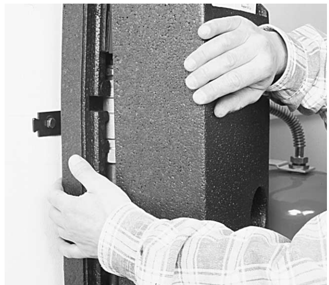
Bild 20 Hintere Isolierschale nach vorne ziehen und vordere Isolierschale andrücken bis sie einschnappt.
