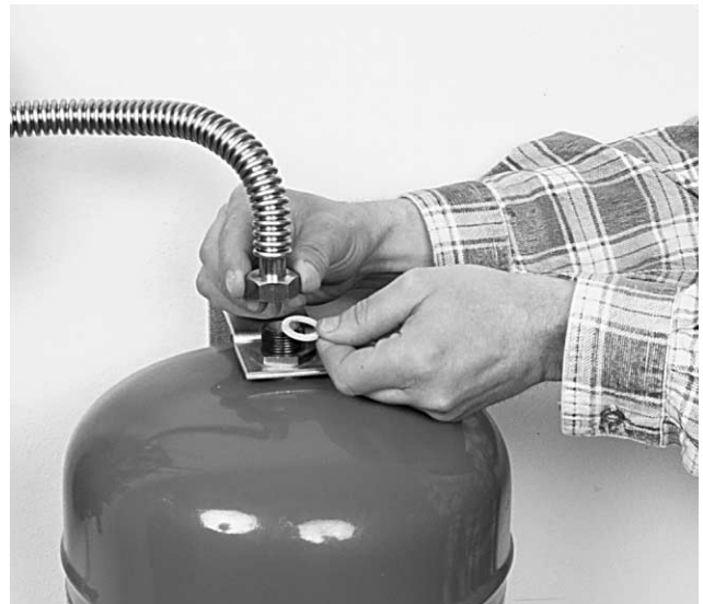
Bild 14 Ausdehnungsgefäß am Halter festschrauben und mit Wellrohr flachdichtend verbinden.
