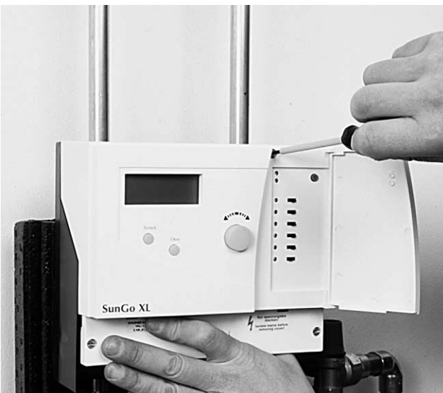
Bild 19 Nach kompletter Verdrahtung Oberteil des SunGo aufstecken und mit drei Schrauben befestigen.
