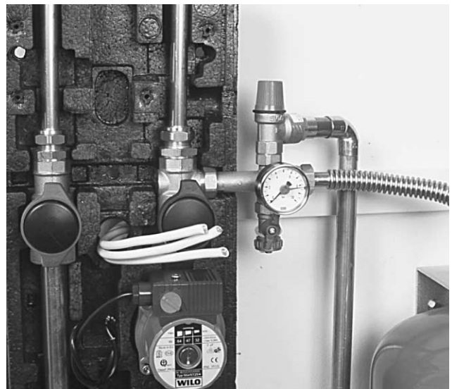
Bild 16 Fühlerkabel im Kabelkanal zur Solarkreisstation legen und durch Öffnung in der unteren Isolierschale nach vorne führen.
