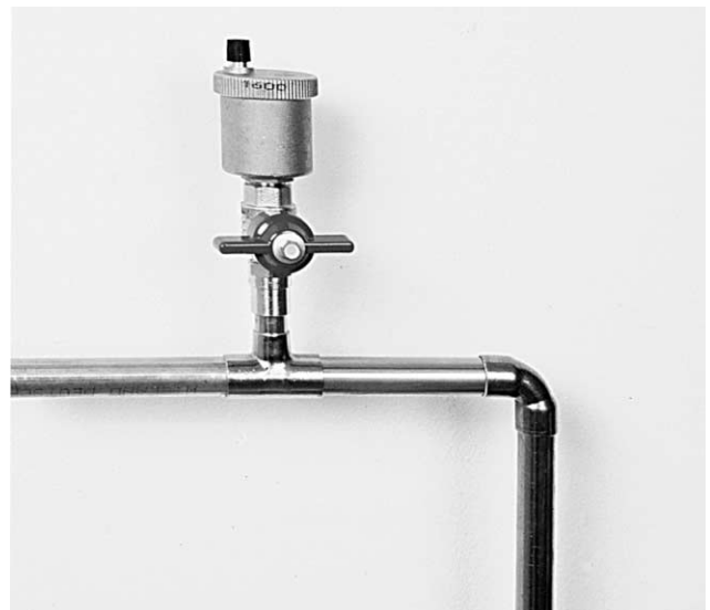
Bild 10 Kollektor über Edelstahlwellschlauch mit Solarkreis verbinden. An allen Hochpunkten Entlüfter einbauen. Statt automatischem Entlüfter mit Kugelhahn auch Handentlüfter möglich.
