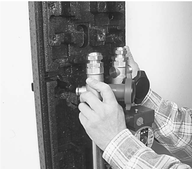
Bild 7 Hintere Isolierschale auf Montageplatte aufschieben und Rohrstränge mit der Adapteröffnung (Rückseite Kugelhähne) in die Befestigungsbolzen der Montageplatte eindrücken.
