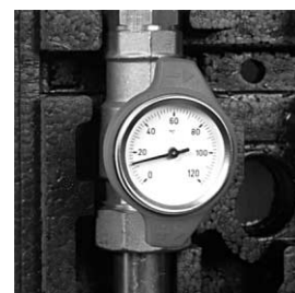
Option Thermometer für Temperaturanzeige Von Vor- und Rücklauf
