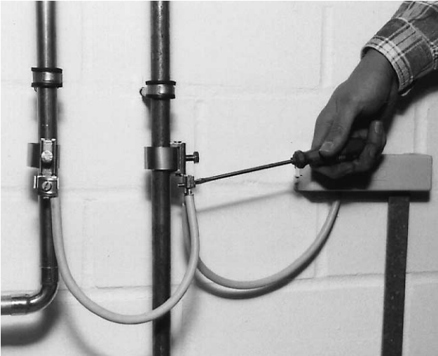
Bild 11 Solarkreis erden. Hierzu Erdungsrohrschellen an beiden Solarkreisrohren anbringen und über 6 mm 2 Kabel mit Potenzialschiene verbinden.
