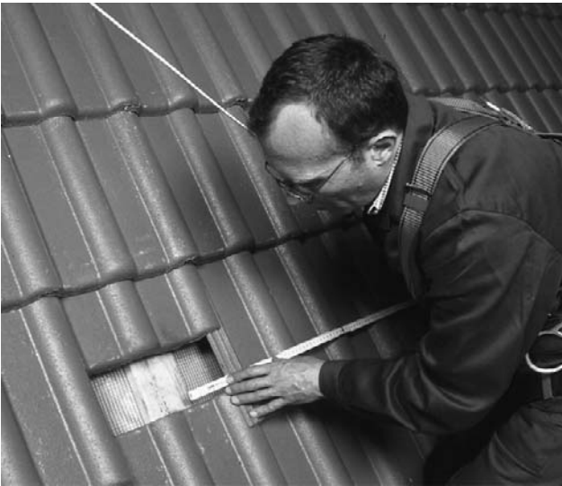
Bild 19 Kollektorfeld auf dem Dach ausmessen und entsprechende Befestigungspunkte auf den Sparren freilegen.
