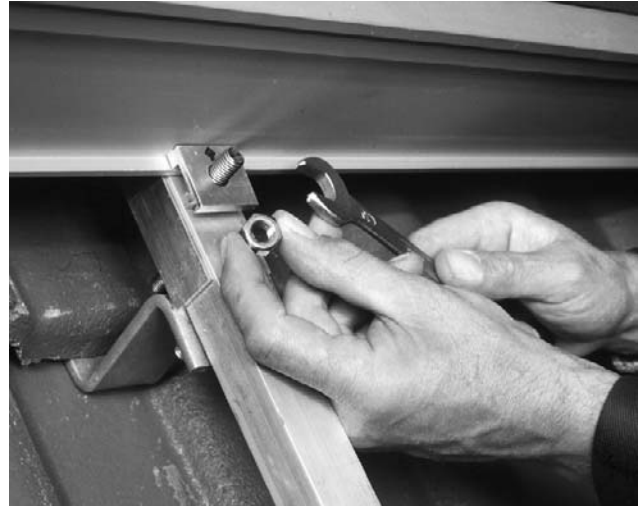
Bild 24 Den Kollektor an der Unterkante und Oberkante mit Befestigungsklemme so an Kollektorschiene fixieren, dass eingepprägter Pfeil zum Kollektor zeigt (s. Lupe 2).
