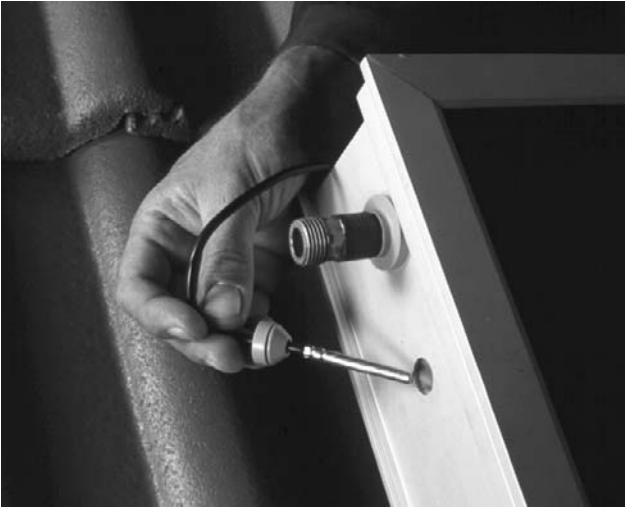
Bild 29 Stopfen aus Fühlerhülse nahe Kollektorfeld-Austritt ziehen und auf Fühler schieben. Fühler in Absorber-Hülse stecken und wieder verschließen. Kabel durch Lüfterziegel zur Fühlerdose legen.
