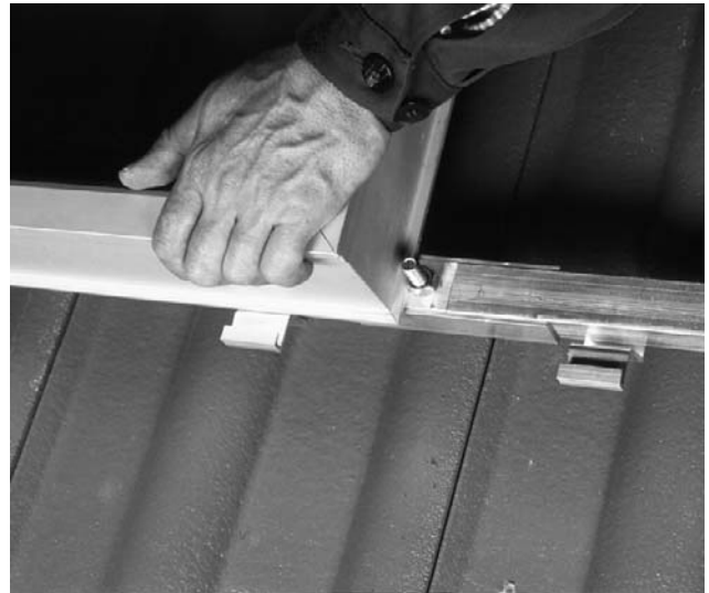
Bild 26 Nur bei senkrechter Anordnung zunächst Kollektoren in Aufdach-Kollektorhalter einsetzen.
