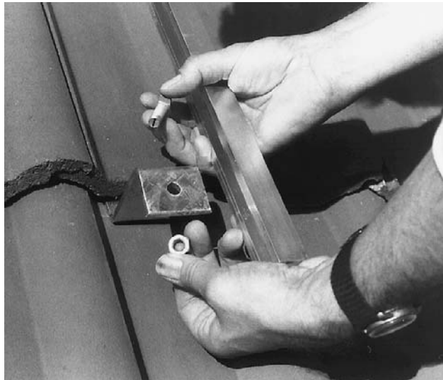
Bild 4 Eine sichere Dachverbindung mit Montageschiene, Hammerkopfschraube und Sparrenanker (hier Typ „P“ für Frankfurter Pfanne und ähnliche Formen).
