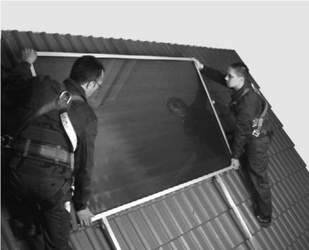
Bild 23 Kollektor an den unteren beiden Schraubbolzen auf den Kollektorschienen absetzen.
