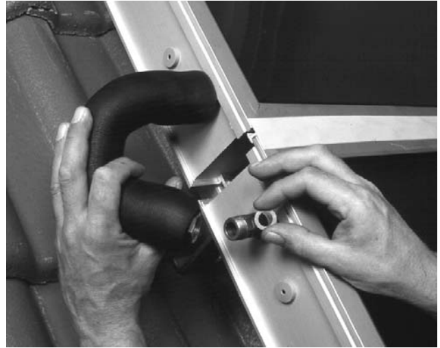
Bild 30 Kollektoren mit Edelstahlwellschläuchen verbinden. Auf Dichtungsringe achten
