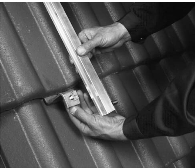
Bild 21 Kollektorschienen auf gleiche Höhe ausrichten und so mit Schrauben an Sparrenankern befestigen, dass der Hammerkopf beim Festziehen quer in der Schiene sitzt.
