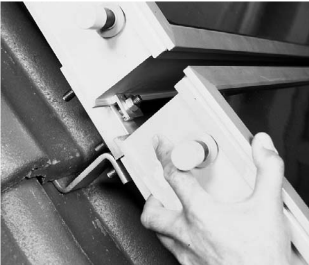
Bild 25 Unteren Kollektor mit der Oberkante unter Befestigungsklemme schieben und die unteren Befestigungsklemmen so festschrauben, dass Pfeil zum Kollektor zeigt.
