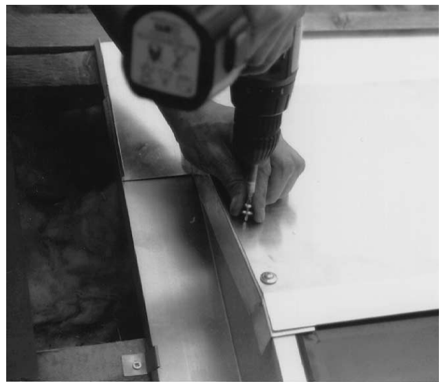
Bild 32 Ecken mit oberem Abschlussblech am Rand mit jeweils 3 Spenglerschrauben (selbstschneidende Schrauben) mit Unterlegscheiben verbinden.
