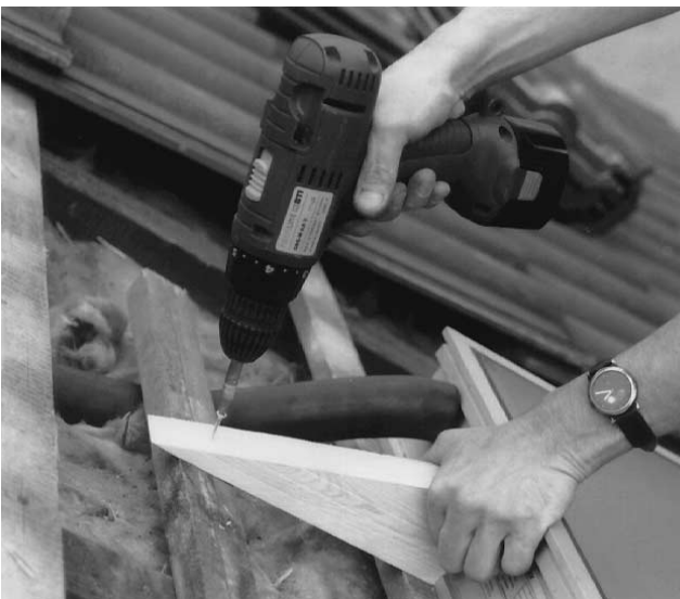
Bild 21 Holzauflage an Kollektor anlegen und mit Schnellbauschrauben befestigen.
