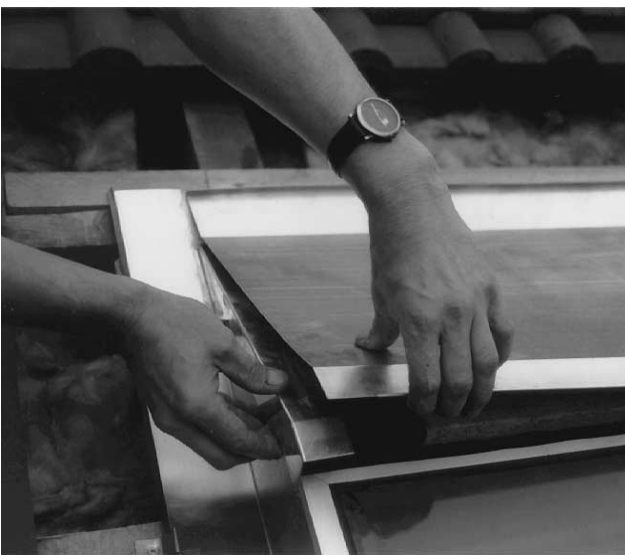
Bild 31 Eindeckecken oben links und rechts auflegen. Auf diese etwas Silikon auftragen. Obere Abschlussbleche auflegen und mit Blechnut in Kollektorfalz einschieben.
