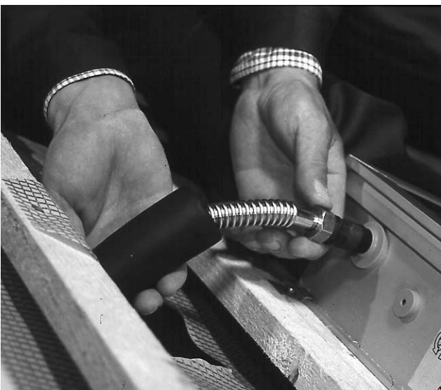
Bild 19 Wellschläuche an freie Kollektoranschlüsse und unterm Dach an Cu-Rohr des Solarkreises (mit 1/2"-18 mm Nippel) anschließen. Verbindungen abdrücken, falls später Dachunterseite geschlossen ist.
