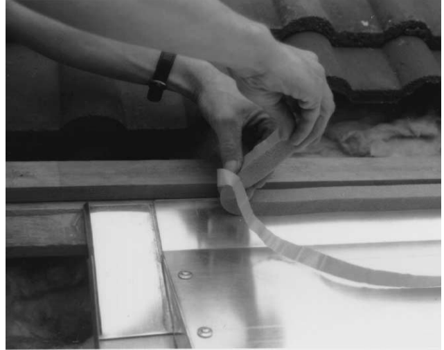
Bild 36 Auf oberes Abschlussblech dickes Schaumgummiband bündig mit dem Falz aufkleben.
