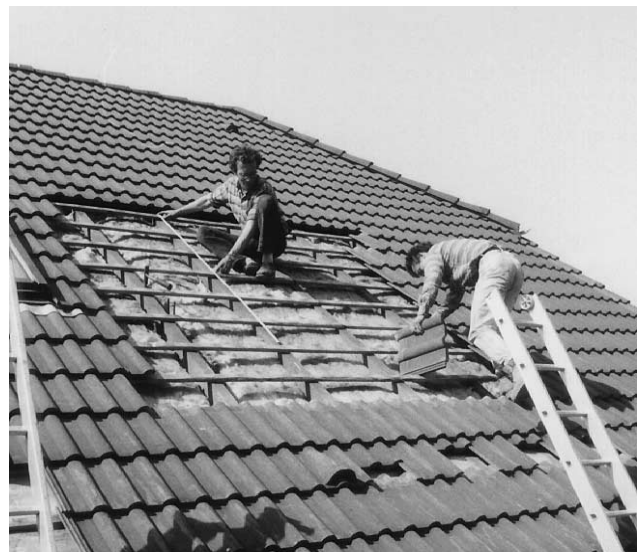
Bild 10 Anhand der Maße und der Schablone (s. Bild 4) Einbaufeld für Sonnenkollektoren auf dem Dach festlegen und Ziegel abdecken.
