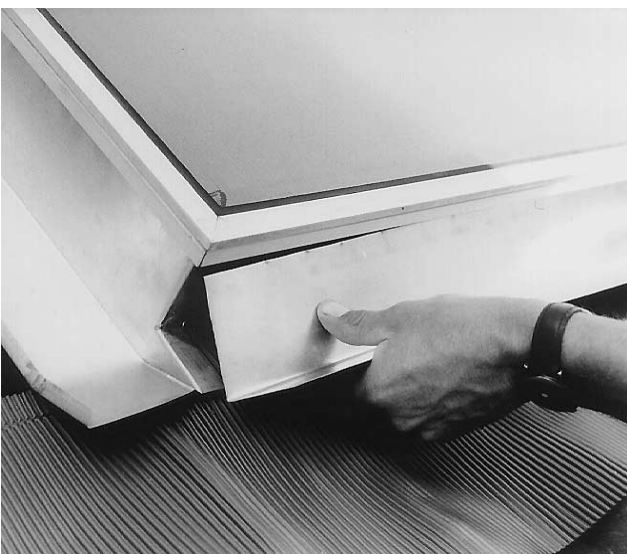
Bild 27 Abschlussbleche unten - am linken Kollektorrand beginnend - in Kollektornut einstecken.
