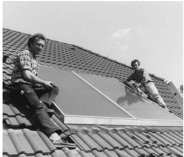
Bild 38 Zum Schluss Bleischürze an Ziegel anpassen. So sind die Kollektoren ansprechend ins Dach eingebunden.
