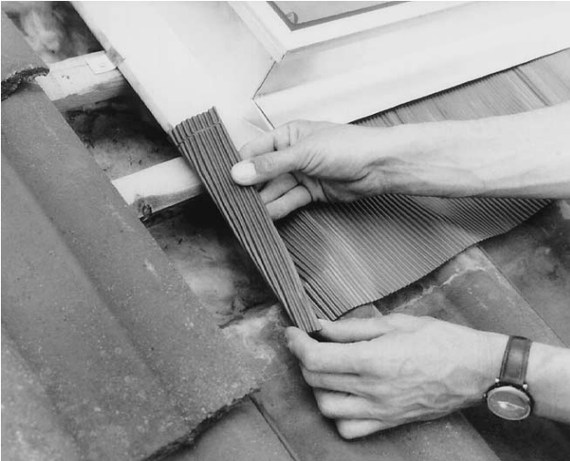
Bild 29 Bleischürze über Seitenbleche umschlagen.
