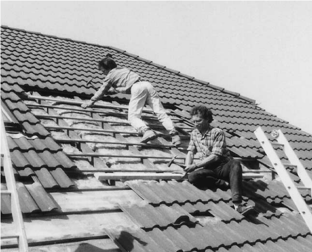
Bild 11 Lage der Latten mit Hilfe der Schablone (s. Bild 4) anzeichnen und Latten mit 65er Nägel befestigen - Latte B schrauben.
