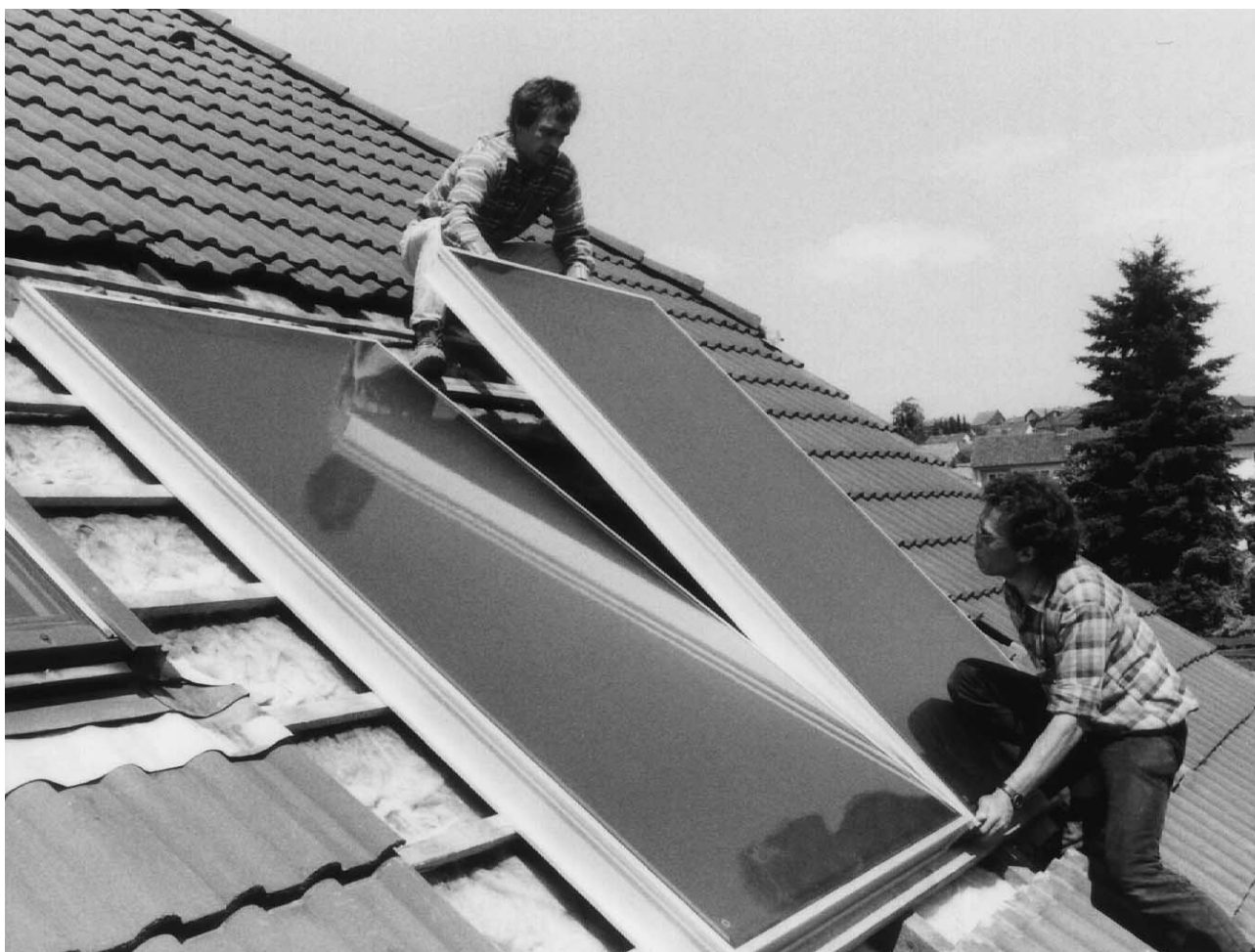
Bild 1 Das EURO-Kollektor Indachsystem lässt sich zu zweit bequem installieren und fügt sich ansprechend in die Dachhaut ein.
