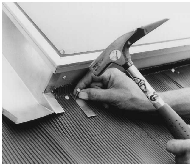
Bild 26 Auf der Bleischürze 3 Blechlaschen pro Kollektor möglichst weit oben befestigen.
