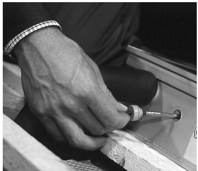
Bild 20 Solarfühler in Fühlerhülse am Kollektoraustritt stecken. Gummistopfen auf Kabel schieben und damit Öffnung verschließen. Kabel ins Dach führen.
