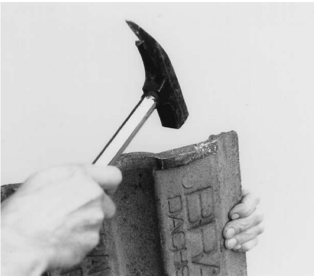
Bild 37 Wenn Sie die Ziegel auf Seitenbleche legen ggf. eine Einhangnocke abschlagen, Ziegel durchbohren und auf Latte (nicht auf dem Blech) festschrauben.
