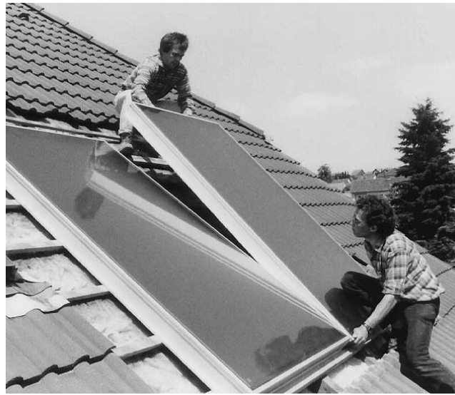
Bild 14 Kollektoren in schräge Latte B gleiten lassen. Zunächst zwischen Kollektoren - zum Einsetzen des Silikon-T-Profiles - einen gleichmäßigen Spalt von ca. 8mm lassen, ggfs. Latte B nachjustieren.
