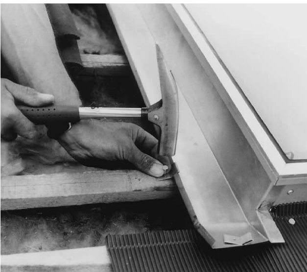
Bild 25 Seitenbleche mit drei Befestigungshaften auf Dachlatten festnageln.
