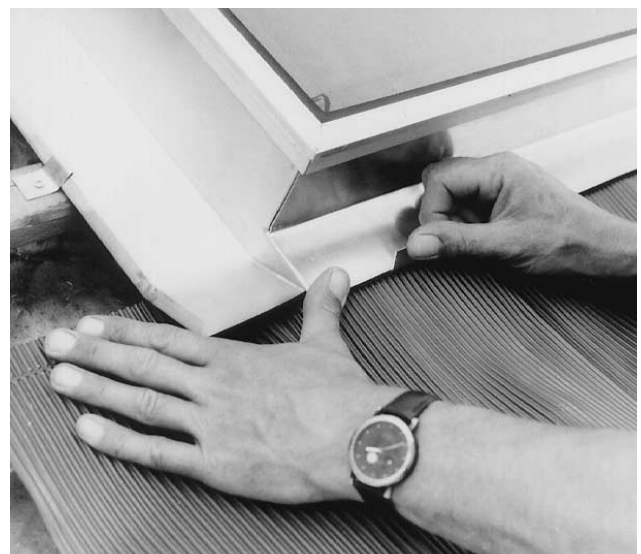
Bild 28 Abschlussbleche unten durch Umbiegen der Blechlaschen fixieren.
