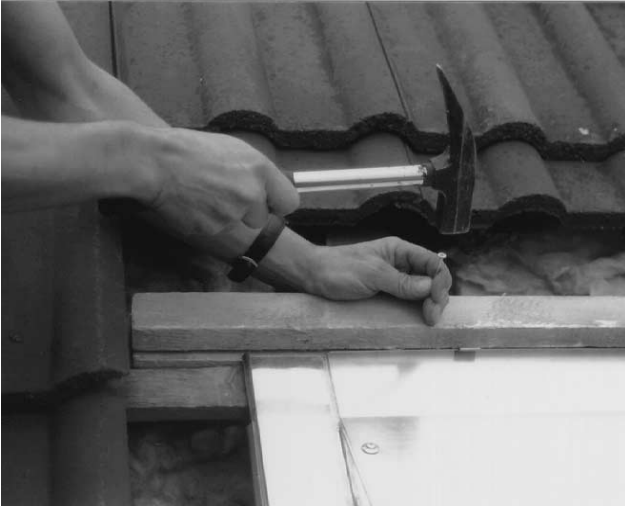
Bild 35 Je nach Ziegeltyp gegebenenfalls zweite Latte von 15 bis 22 mm aufnageln, damit die Neigung der Ziegel mit denen in anderen Reihen übereinstimmt.
