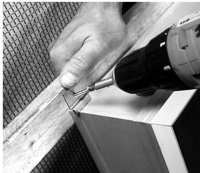
Bild 16 Sonnenkollektor oben jeweils links und rechts an der Kante mit Kollektor-Indachhaltern auf Latten festschrauben.
