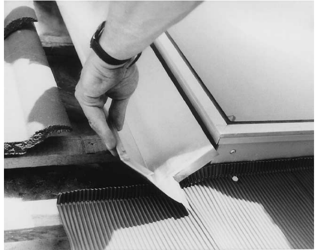
Bild 24 Seitenbleche in die tiefe Nut am Kollektor einstecken. Unten ragt es dann über die Bleischürze.
