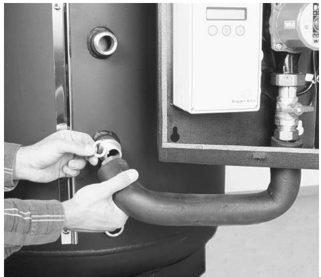
Bild 21 Anschließend zweiten Wellenschlauch am untersten Anschluss befestigen. Flachdichtungen nicht vergessen!
