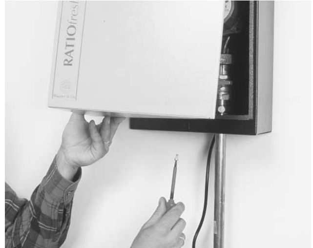
Bild 17 Einstellung des Reglers nach Anleitung. Dann Gehäuse schließen und mit der Blechschraube von unten sichern.
