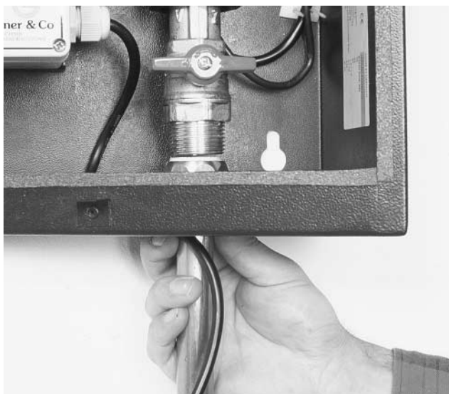
Bild 8 Primär-RL-Leitung anschließen und in den untersten Anschluss des Speichers führen. Flachdichtungen nicht vergessen !
