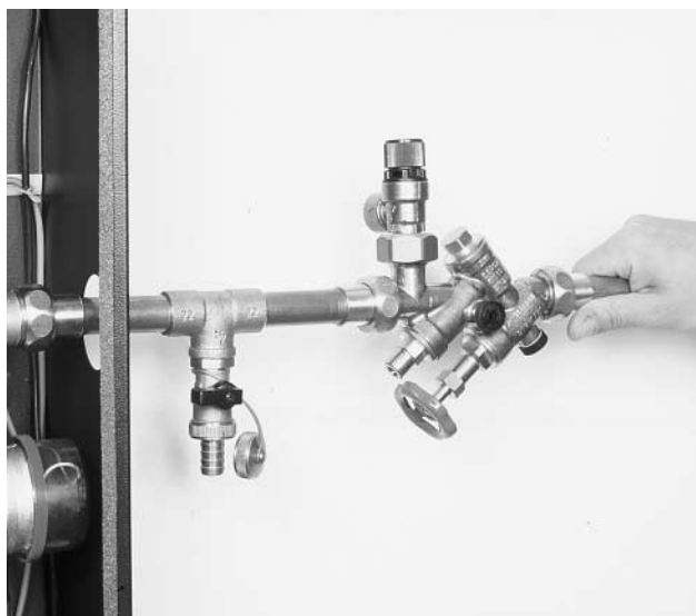
Bild 9 Kaltwasser nach Anschlussplan anschließen. (Alternative zu Absperr-, Rückschlag- u. Sicherheitsventil: Sicherheitsgruppe ). Keine Absperrung zwischen Ratiofresh-Station und Sicherheitsventil!
