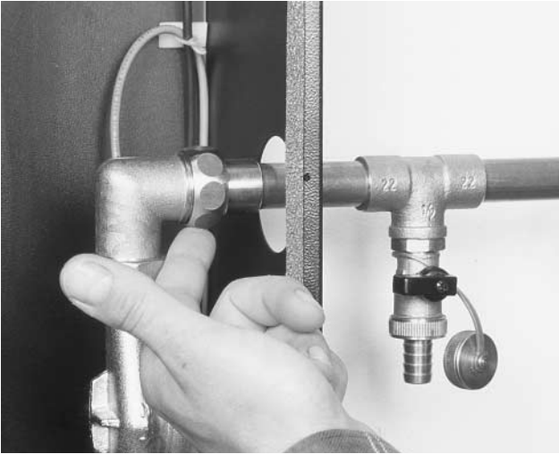
Bild 16 Nach hydraulischem Anschluss aller Leitungen Kaltwasser aufdrehen, Zapfstelle zum Entlüften öffnen, dann schließen und Ratiofresh-Frischwasserstation auf Dichtheit prüfen.
