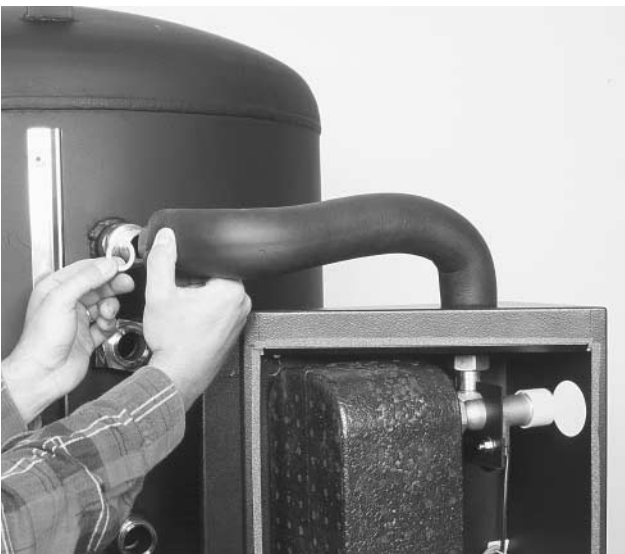
Bild 20 Als PVL Wellenschlauch am obersten Pufferanschluss montieren. Darauf achten, dass der Wellenschlauch zum Speicher hin stegig steigt, um eine Entlüftung zu ermöglichen.
