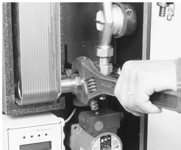
Bild 26 Entlüftung am PVL öffnen und Wärmetauscher pimärseitig durch Lösen der 1"-Überwurfmutter am PRL entleeren. Zur Demontage der Wärmetauschers alle vier 1"-Überwurfmutter lösen.
