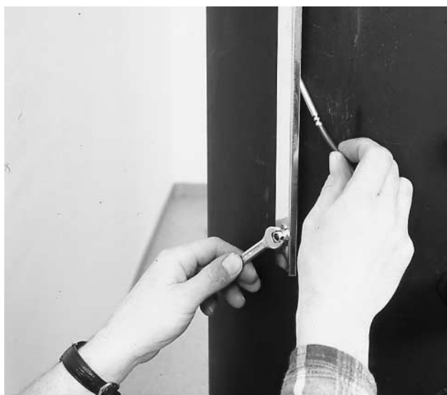
Bild 7 Im Nachheizbereich des Pufferspeichers den mit „Tprim“ gekennzeichneten Temp.fühler mit Klemmleiste oder Tauchhülse befestigen. Achtung! Fühler muss die Primärvorlauftemp. korrekt erfassen.
