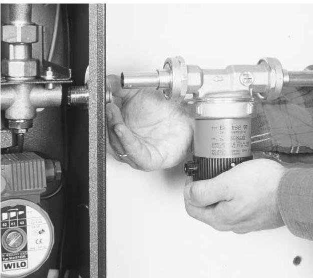
Bild 12 ... und Zirkulations-RL-Leitung nach Anschlussplan montieren. (Pumpe und Rückflussverhinderer bauseits erstellen.)
