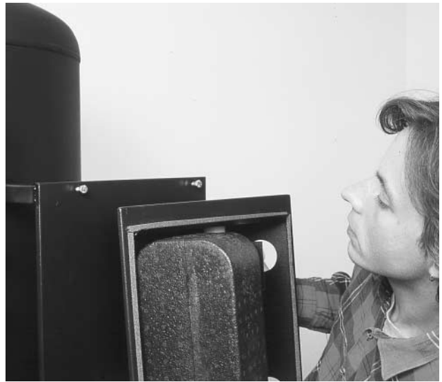
Bild 19 Schlosssechskantschrauben halb in die Montageplatte eindrehen. Dann Gehäuseunterteil mit Schlüsselbohrungen einhängen und Schlossschrauben festziehen.
